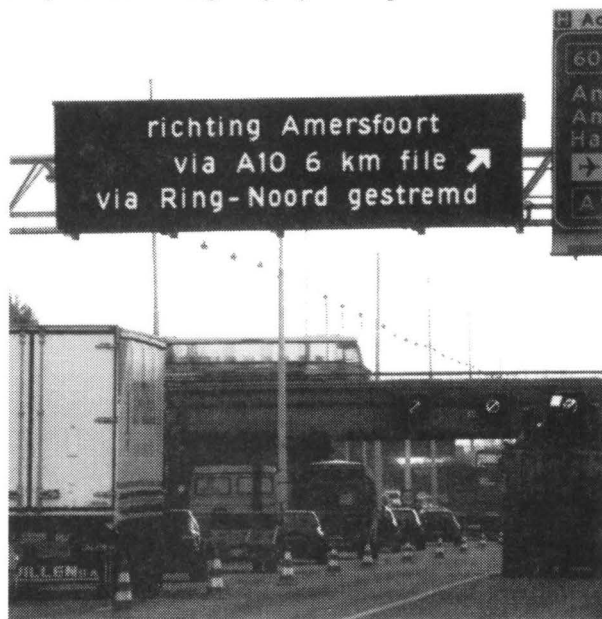
Dynamische Route Informatie Paneel (DRIP) in de omgeving van Amsterdam. Bron: Traffic Technology International, June/ July 1997.
