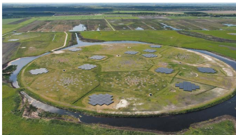
Der „Superterp“ unweit von Exloo in den Niederlanden. In den eckigen Kästen sind die Antennen für die kurzwellige Radiostrahlung untergebracht. Dazwischen erkennt man die Drahtantennenfelder für den langwelligen Frequenzbereich.
