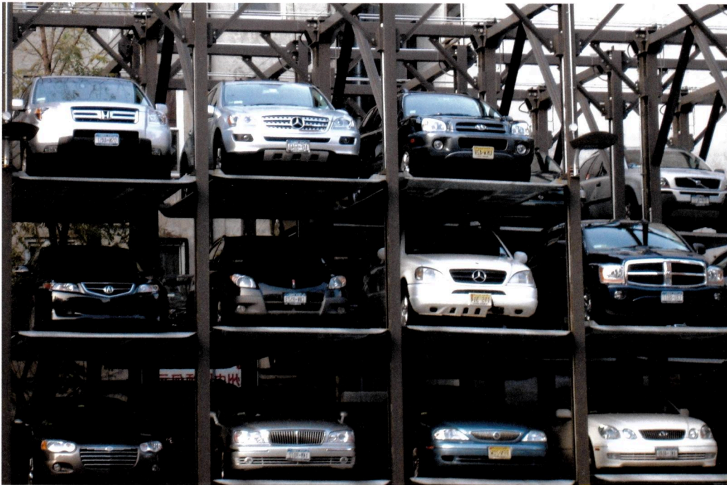
Automatische parkeergarage in Chinatown, New York
